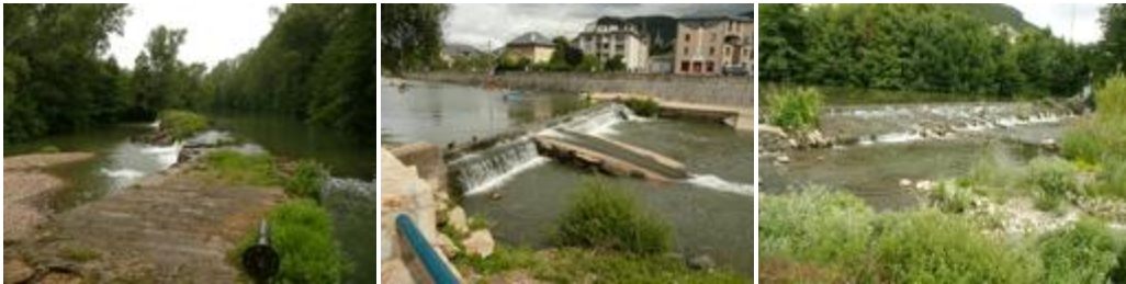
Figure 26 : Exemples de seuils artificiels difficilement franchissables par la faune piscicole
