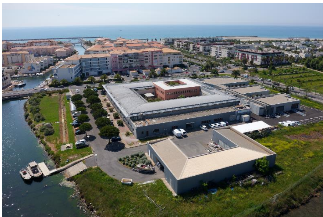
Le bâtiment Celimer, à droite, vient compléter la station Ifremer de Sète. © Ifremer - Stéphane Lesbats
