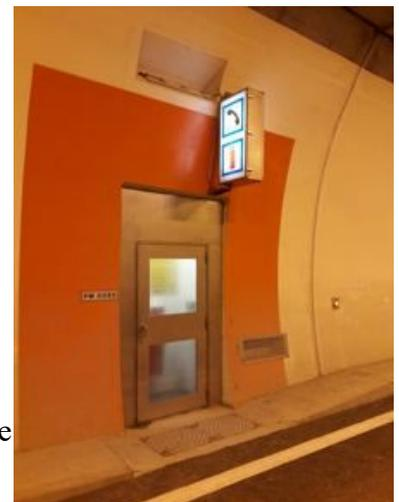
La signalisation des galeries d'évacuation est matérialisée par de la couleur verte pour rassurer l'utilisateur et l'inciter à gagner cette zone dans laquelle il sera en sécurité. Des panneaux de direction jalonnent tout le tunnel pour indiquer leur distance pour les rejoindre.
